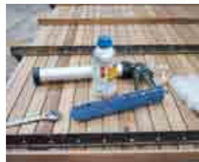
Abb. 16 Stabdeck zur Aushärtung eingespannt
