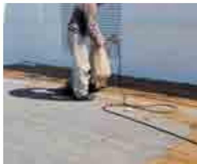
Abb. 12 Deck mit einer Industriebandschleifmaschine abschleifen
