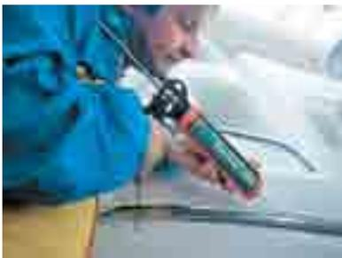
Abb. 25 Abdichten der Flanken einer Scheuerleiste aus Chrom
