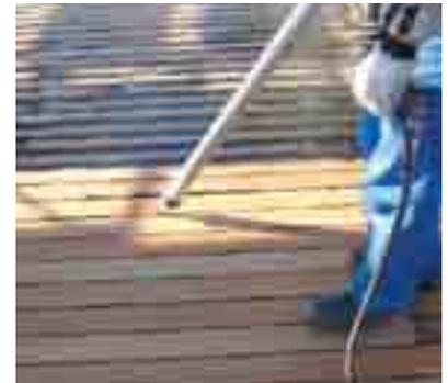
Abb. 14 Mit Sikaflex®-290 DC verfugen
