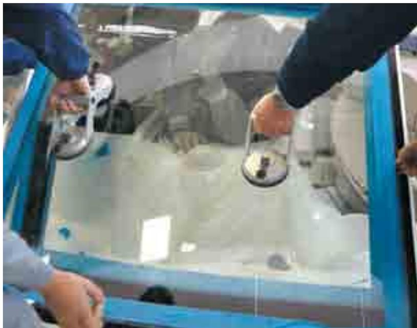
Abb. 45 Fenster einsetzen
